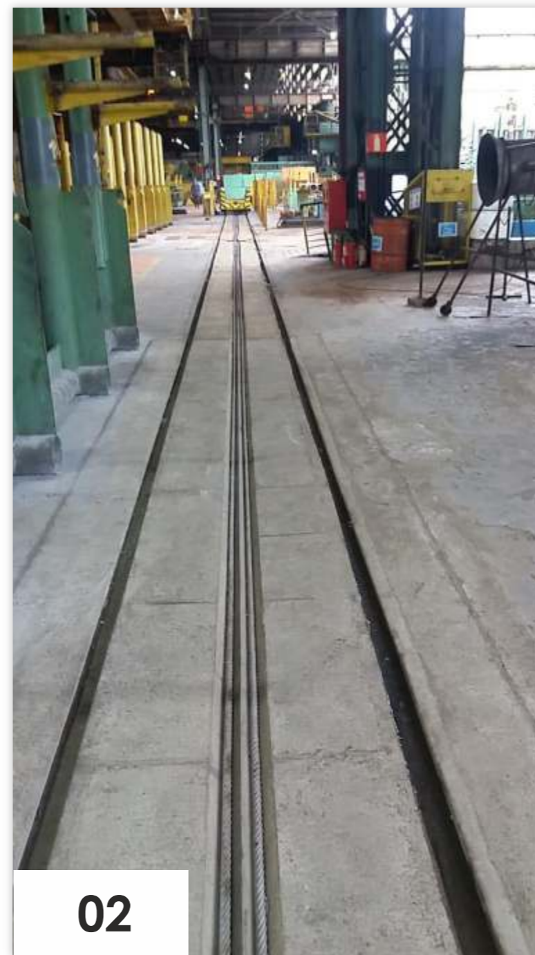
COMPLEMENTAÇÃO DOS TRILHOS DA DA VAGONETA - DEPOIS
